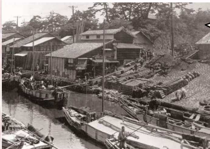
荷揚げ風景の写真
