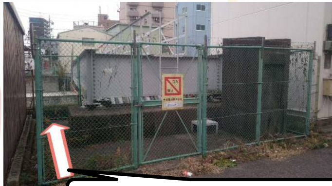
道路側からの出入口を設置
