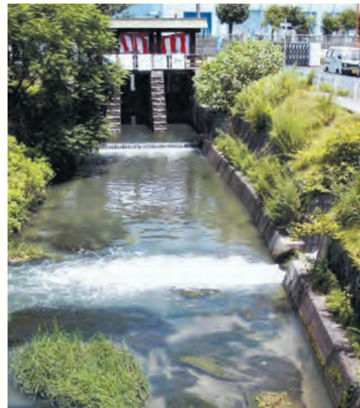
堀川に流れ込む地下鉄工事の地下水
