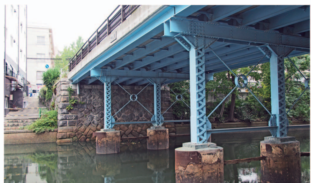
鋼材をリベット接合した橋脚をもつ堀川で一番古い中橋（大正6年築） 左手に往時の物揚場のスロープが残る
