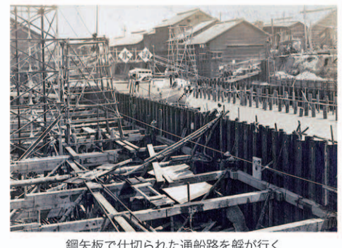
鋼矢板で仕切られた通航路を解か行く
