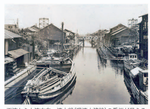
下流から上流方向 清水組(現清水建設)の看板が見える
