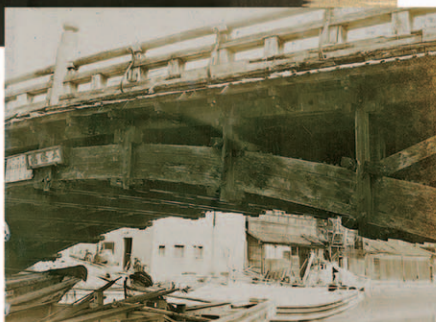
▲ 五條橋の橋台部分(現在) アーチリブの沓(支承)の穴をセメントで埋めた跡
