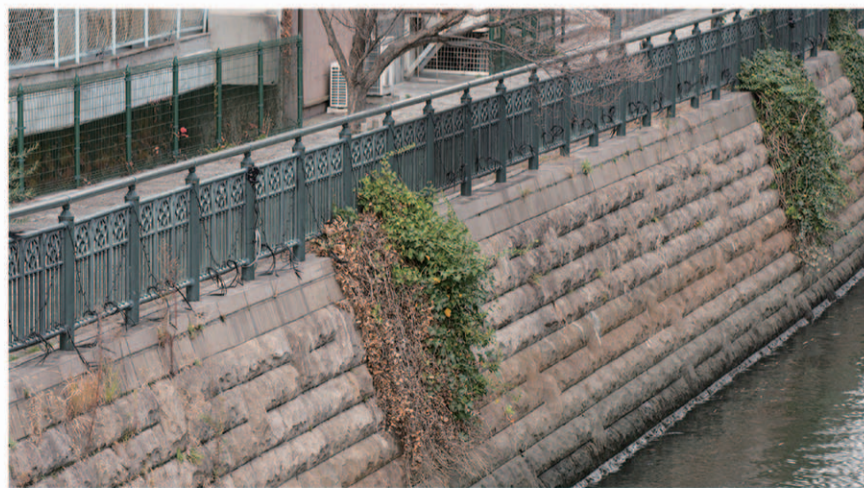
化粧パネル 納屋橋上流
