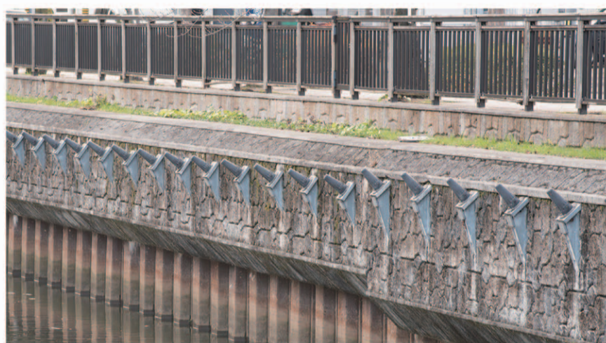
鋼矢板+アースアンカー 中土戸橋上流
