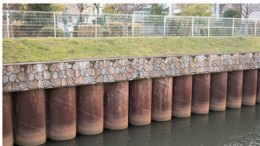
鋼管矢板 堀端橋下流
