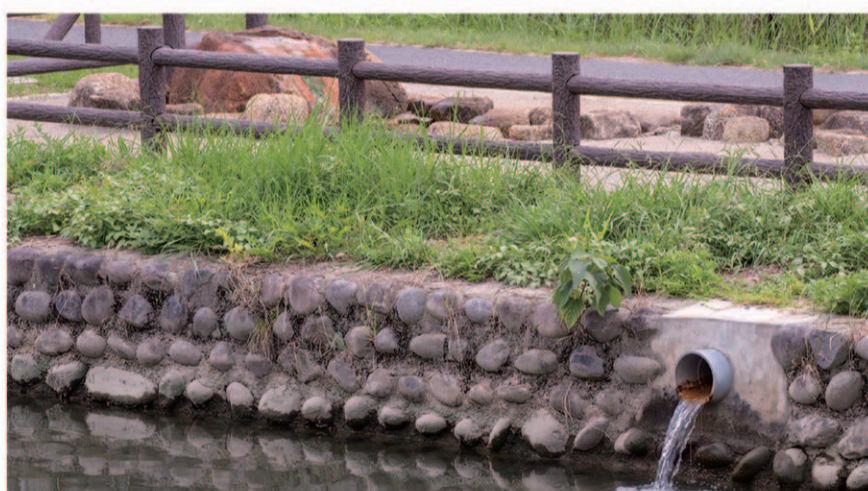
野面石積 瀬古橋上流
