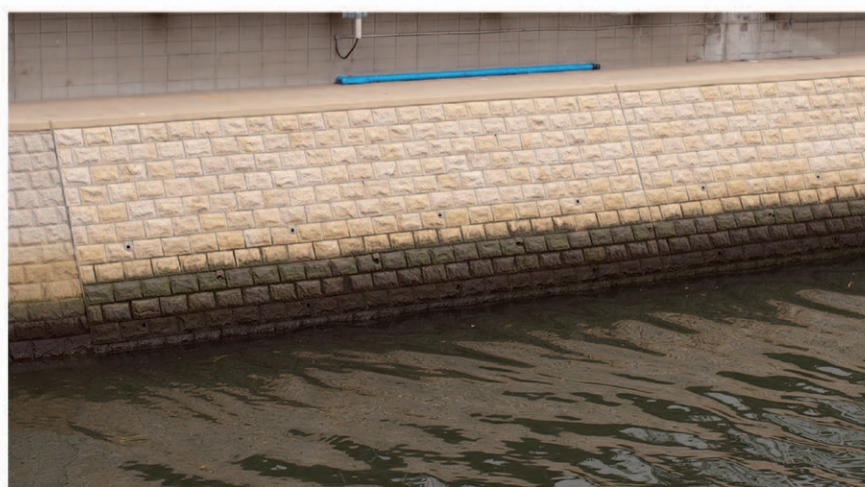
ブロック積 新洲崎橋上流
