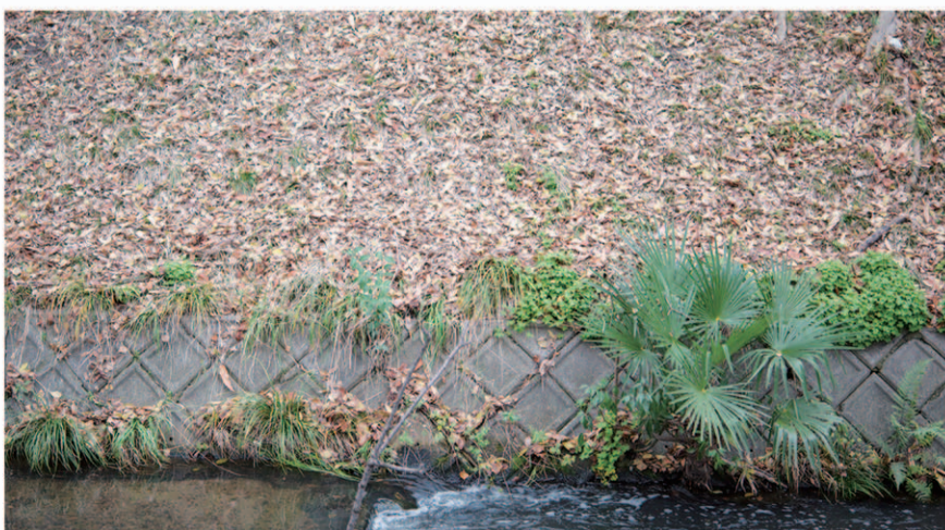
ブロック積+土手 夫婦橋下流
