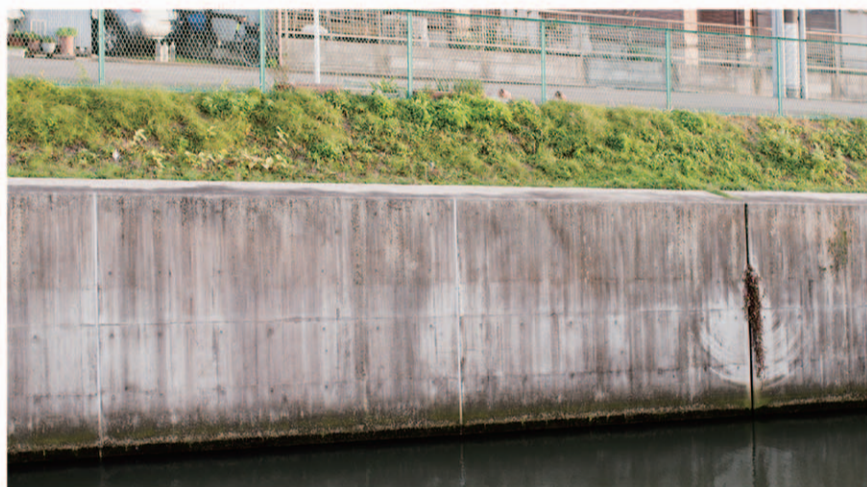
新しい護岸 筋違橋上流
