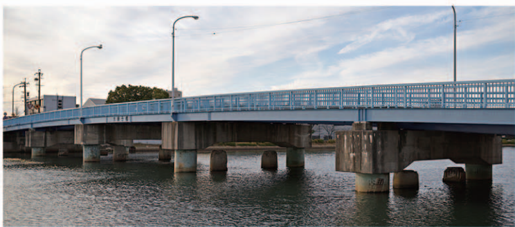
橋脚付鋼桁橋 大瀬子橋
