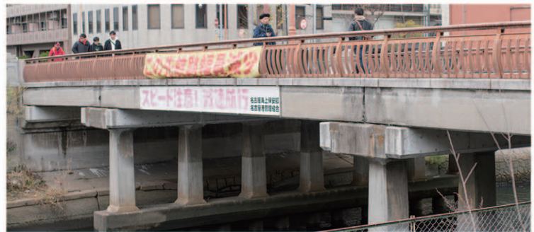
橋脚付鉄筋コンクリート桁橋 天王崎橋
