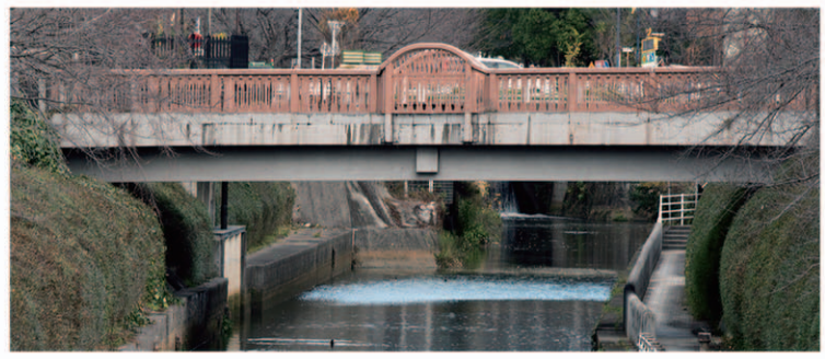
鉄筋コンクリート桁橋 黒川橋
