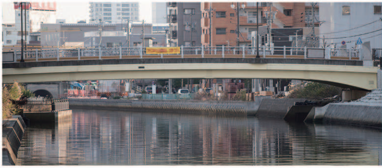
鋼桁橋 尾頭橋
