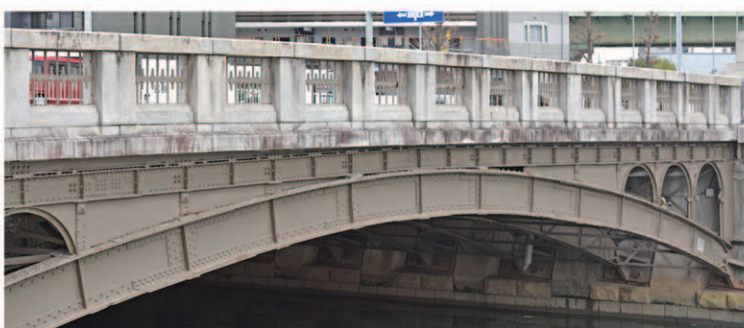
鋼アーチ橋 岩井橋
