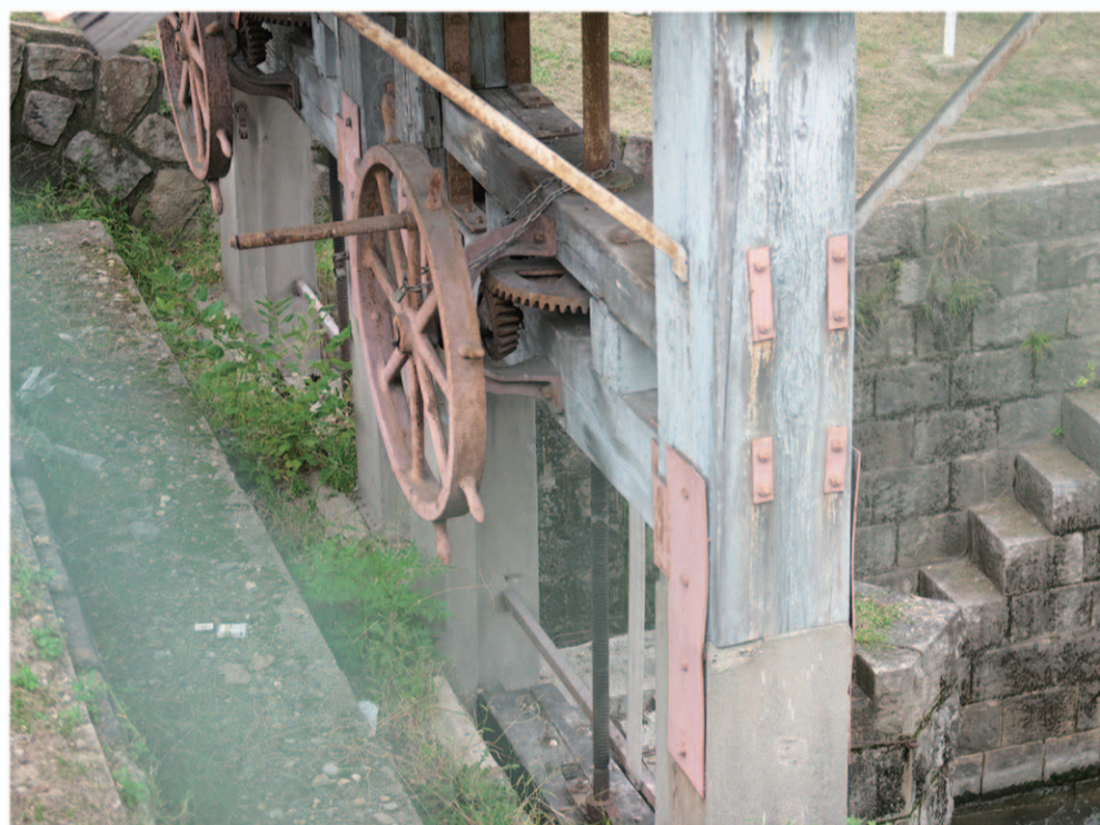
ゲートを上下させるハンドルと歯車装置
