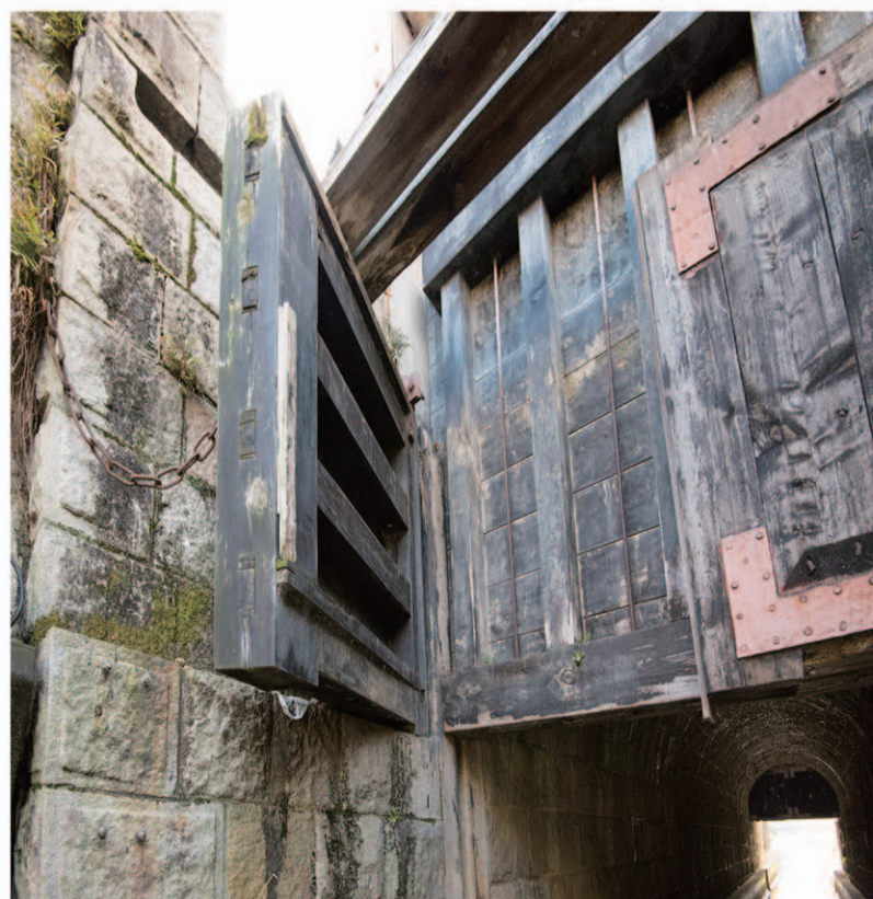
上げた状態の上下スライド式ゲートと片側を開けた観音開きゲート
