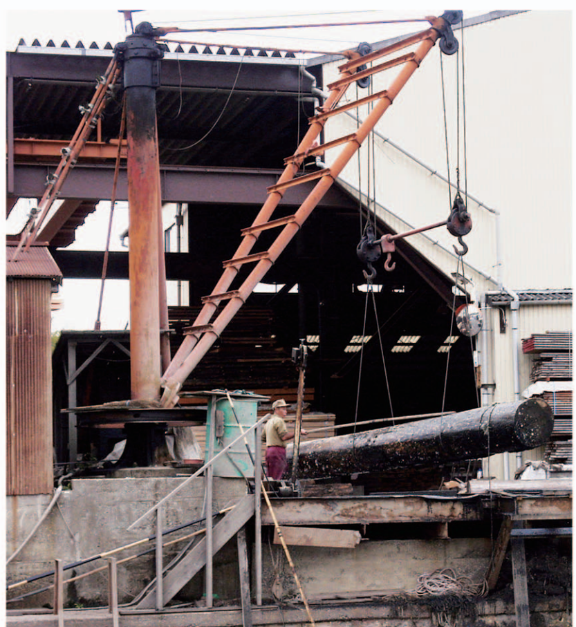
クレーンによる巨木陸揚作業
