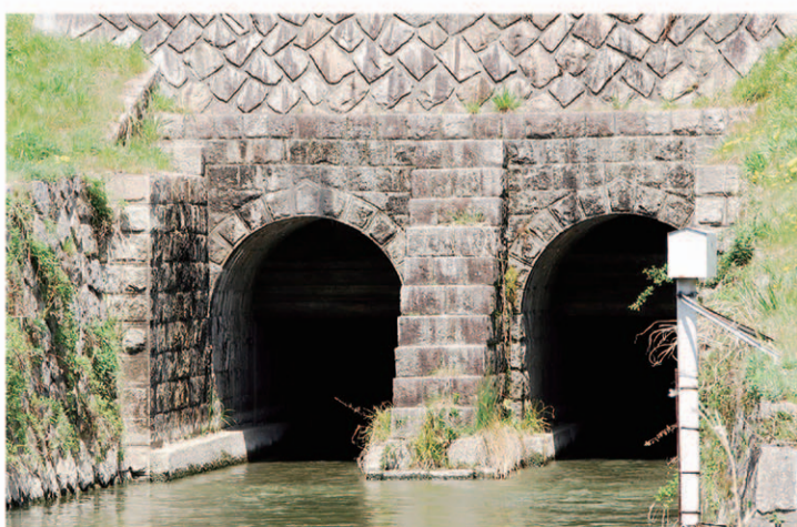
丈の高いトンネル
