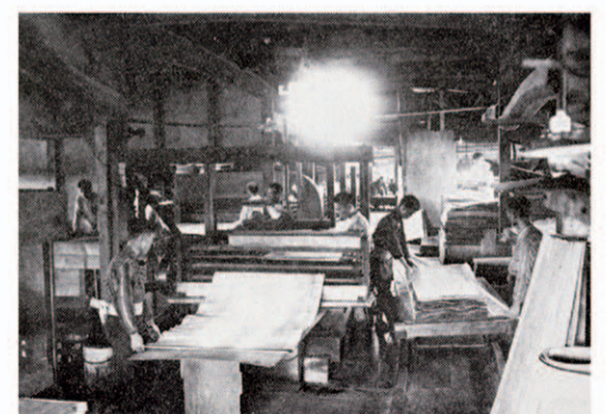
のり付け作業 (上下とも『合板七十五年史』)
