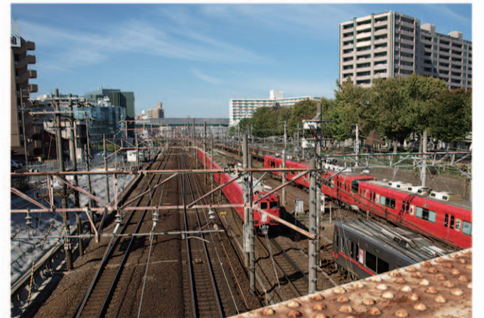
現在も堀川橋梁を主要な鉄道が渡る。左から東海道線、名鉄線、中央線。いま左手を走行している赤い電車が明治19年建造の橋脚上を通過することになる名鉄線下り。(正木橋から堀川方面に向け撮影)
