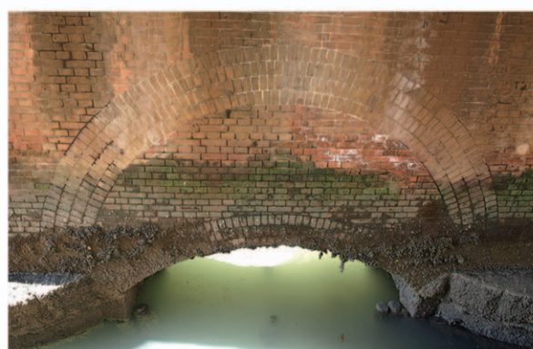
上：④の橋脚の土台部分 土台もレンガを使用
