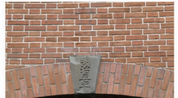
上：堀川の橋脚は横一列にレンガの長辺または短辺だけを揃えて積み上げるイギリス積みである(関西に多く、イギリスからの技術指導の影響が見受けられる) 下：群馬県富岡製糸場の置簾所外壁 レンガの短・長辺を横に交互に並べて積み上げるフランス積みである(関東に多い)
