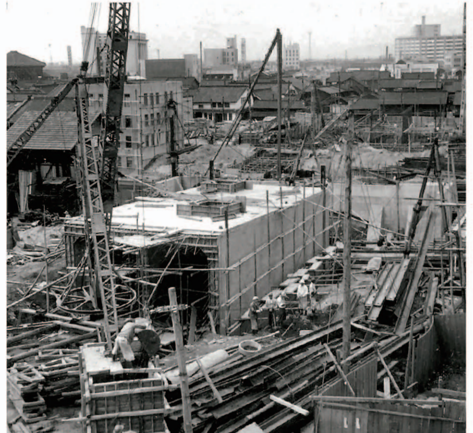
潜函工法 地上の現場（名古屋市交通局提供）
