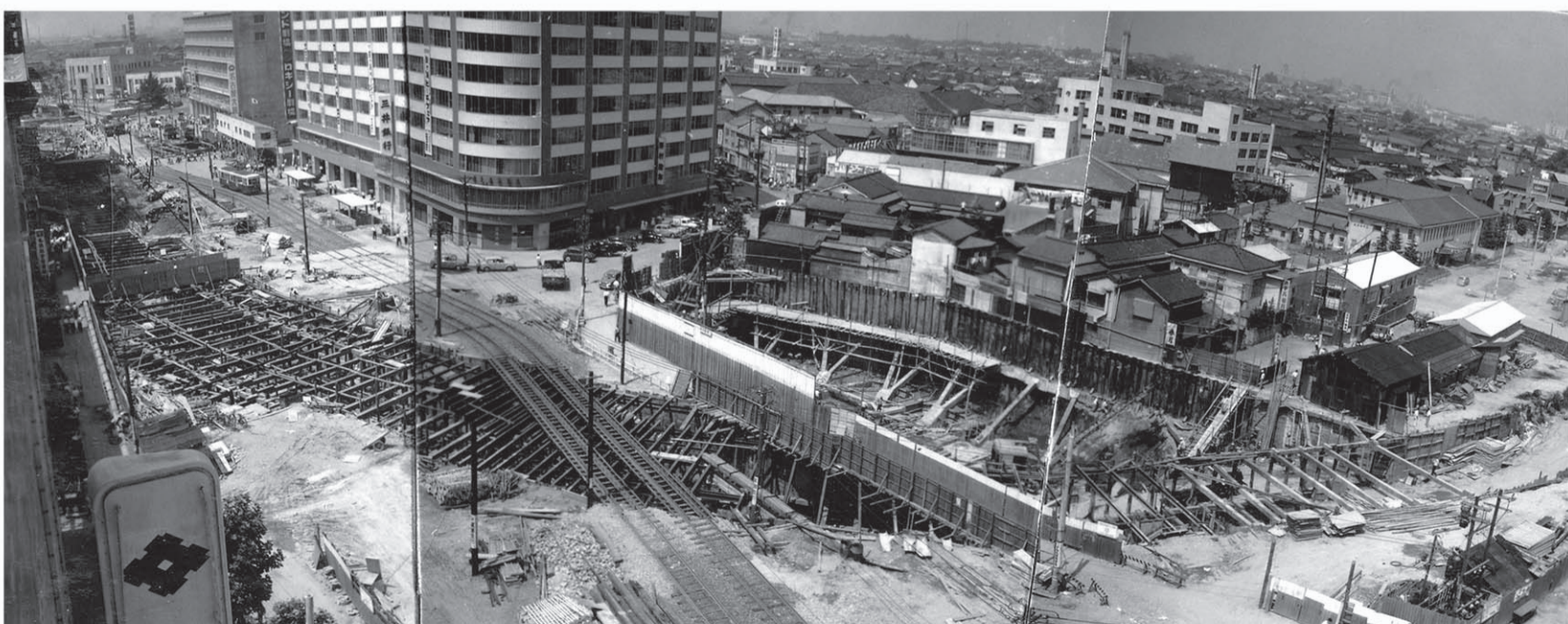
オープンカット工法で進む笹島付近の地下鉄工事現場 写真を合成（昭和30年頃 名古屋市広報課提供）
