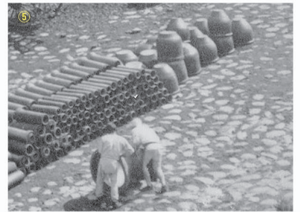
⑤ 2人がかりで土管を転がして運んでいる。大きな土管だ。下水の本管にでも使うのだろう。向こうには細い土管と大きな瓶が並べられている。
