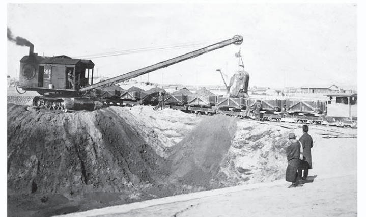
重機で掘削、トロッコで運搬 (名古屋市市政資料館蔵)
