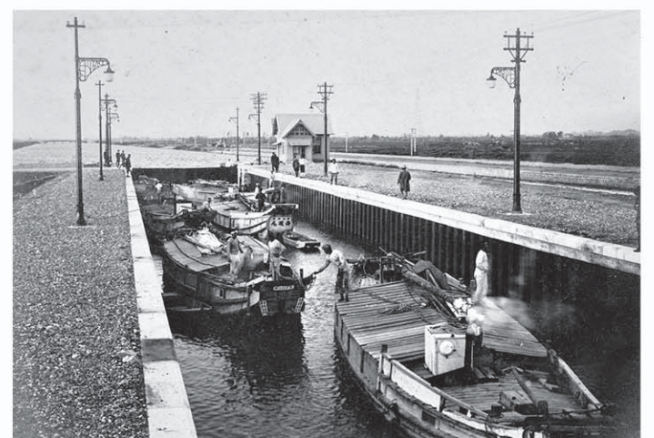
完成した中川口閘門 (名古屋市市政資料館蔵)
