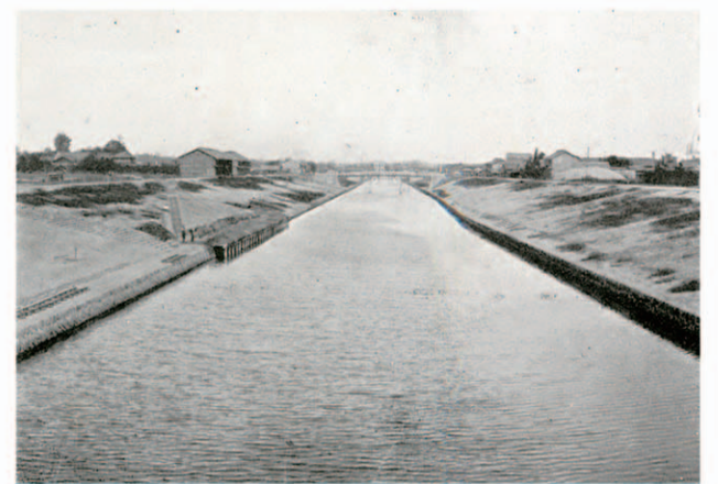
改修なった精進川(新堀川)
